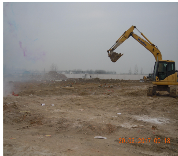
主厂房土方开挖
