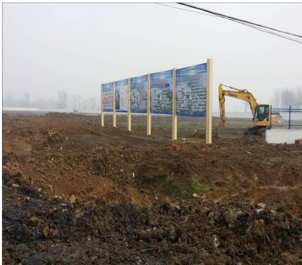
厂区路基施工
