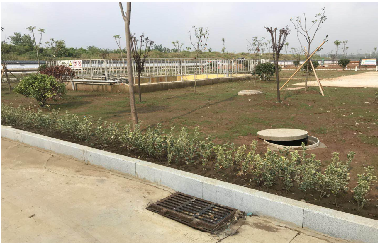
图片4 主厂房周边绿化及排水系统
