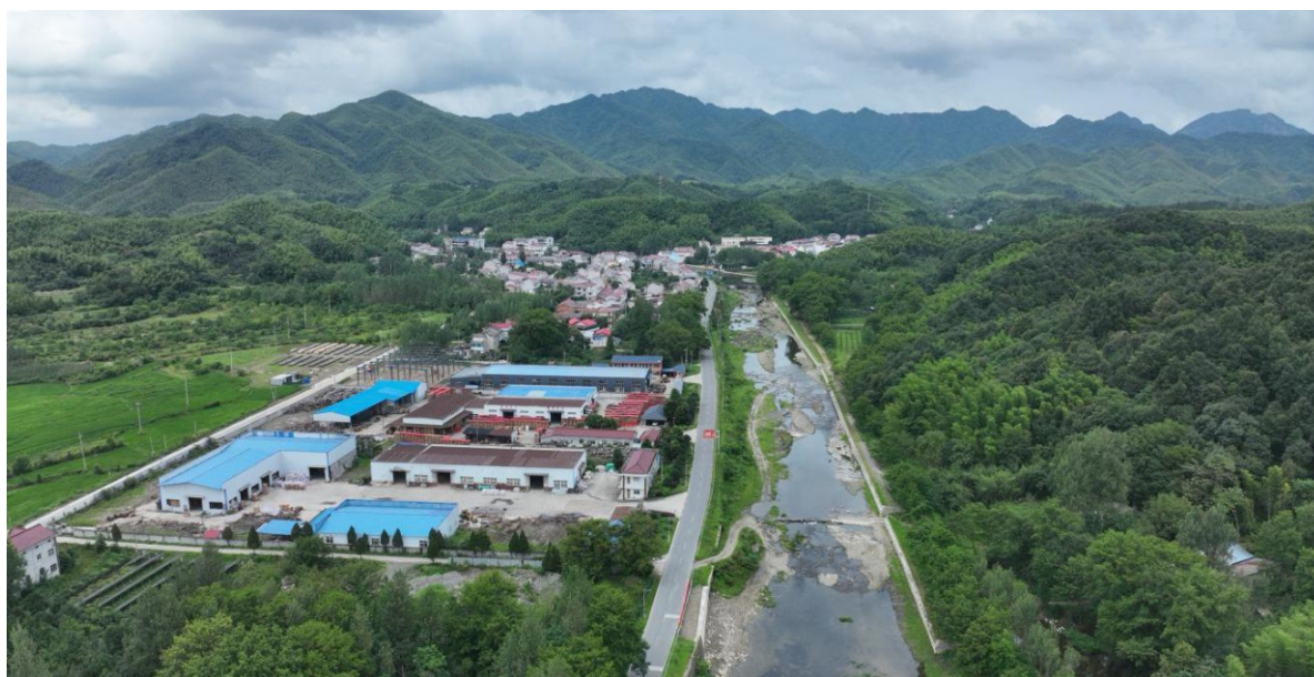
裕安区2025年吴家畈项目区小流域综合治理提质增效项目 (护岸工程及生态景观带)
