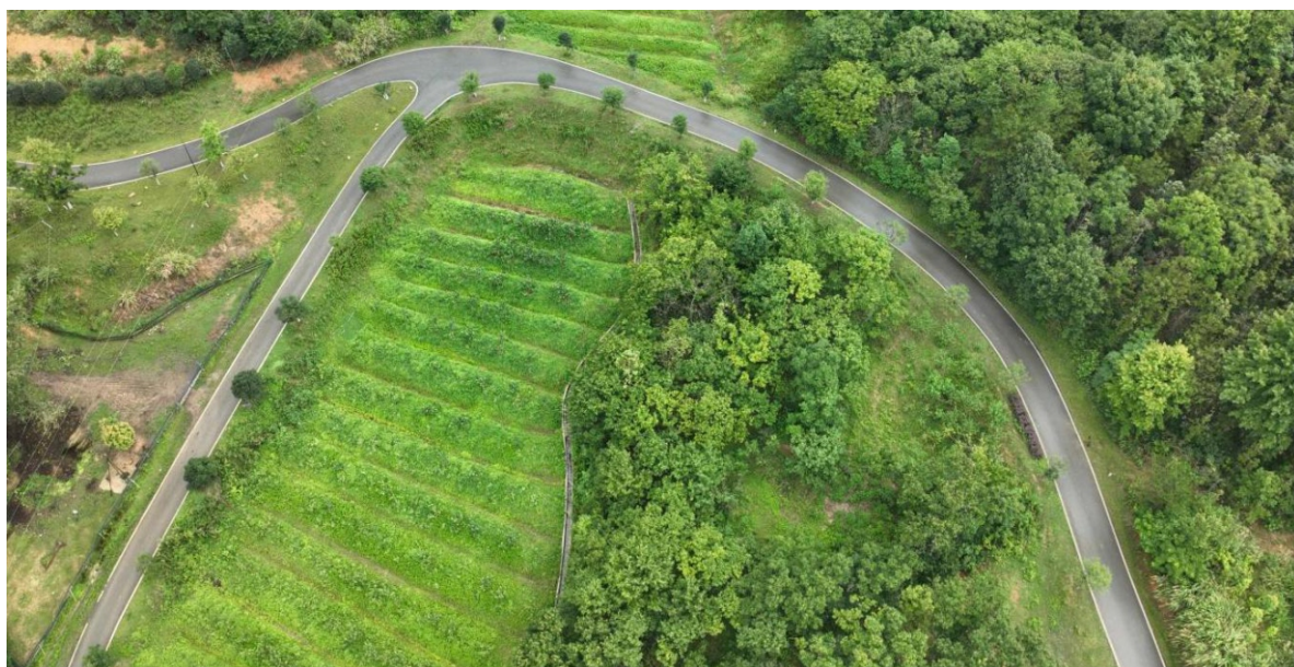
舒城县2025年大柳树项目区小流域综合治理提质增效项目 (水蚀坡林地综合整治)
