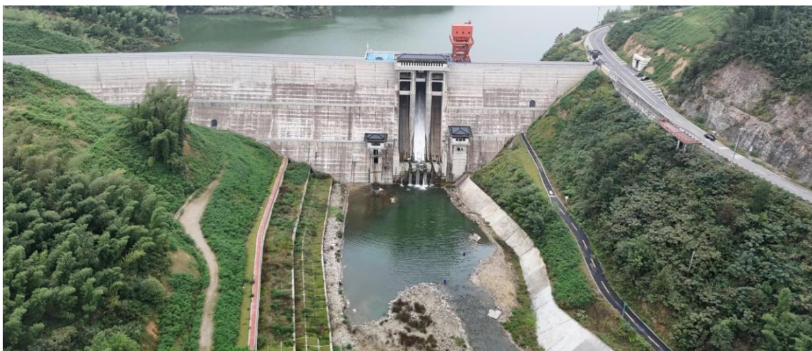
霍山县桃源河水库工程植草护坡
