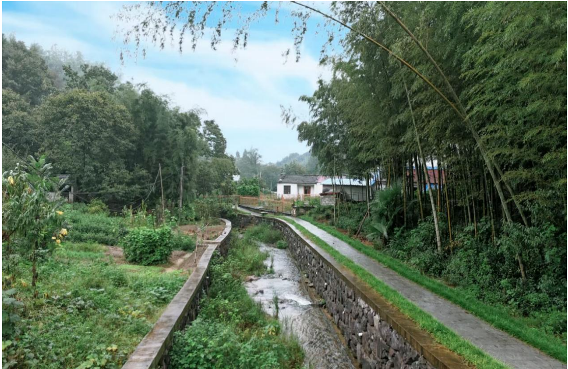
图3-4 霍山县东城小流域水土保持综合治理工程（河道护岸+人行步道）
