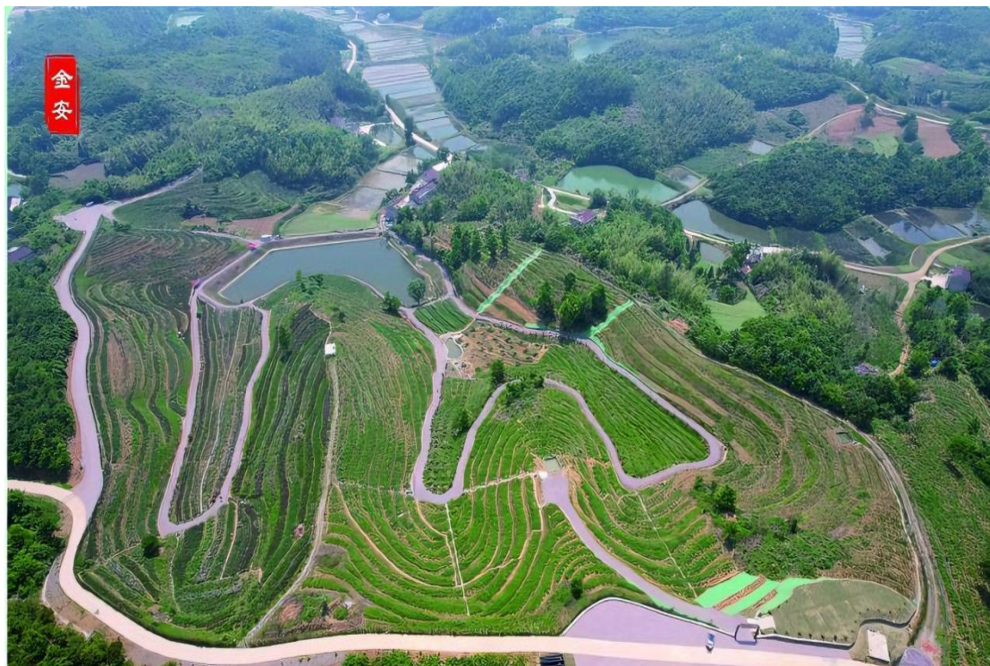
图3-1 金安区2024年水土保持工程建设以奖代补试点项目 (银马生态园坡耕地综合整治项目)
