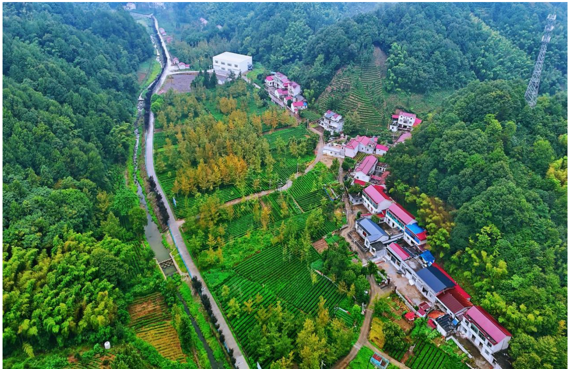
图3-9 裕安区独山小流域水土保持综合治理工程 (水蚀坡林地+道路绿化+拦沙坝)
