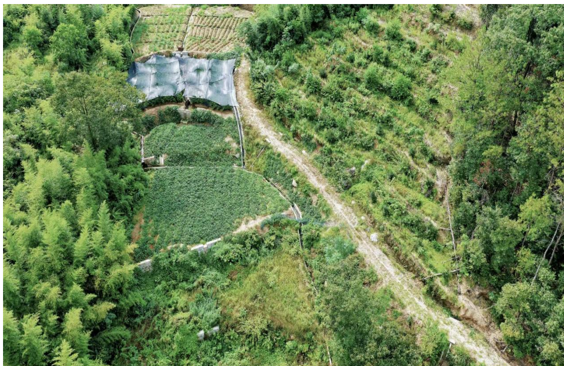
图3-2 金寨县月亮冲小流域水土保持综合治理工程 (水蚀坡林地+坡地梯田综合整治)
