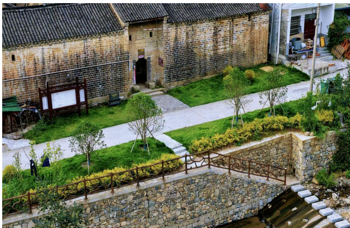
图3-6 金寨县近水沟小流域水土保持综合治理工程（拦沙坎+滨河植物带）
