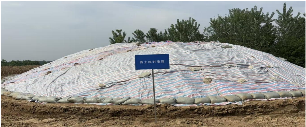
图2-1 安徽省沿淮行蓄洪区等其他洼地治理工程（裕安区段）表土剥离保护
