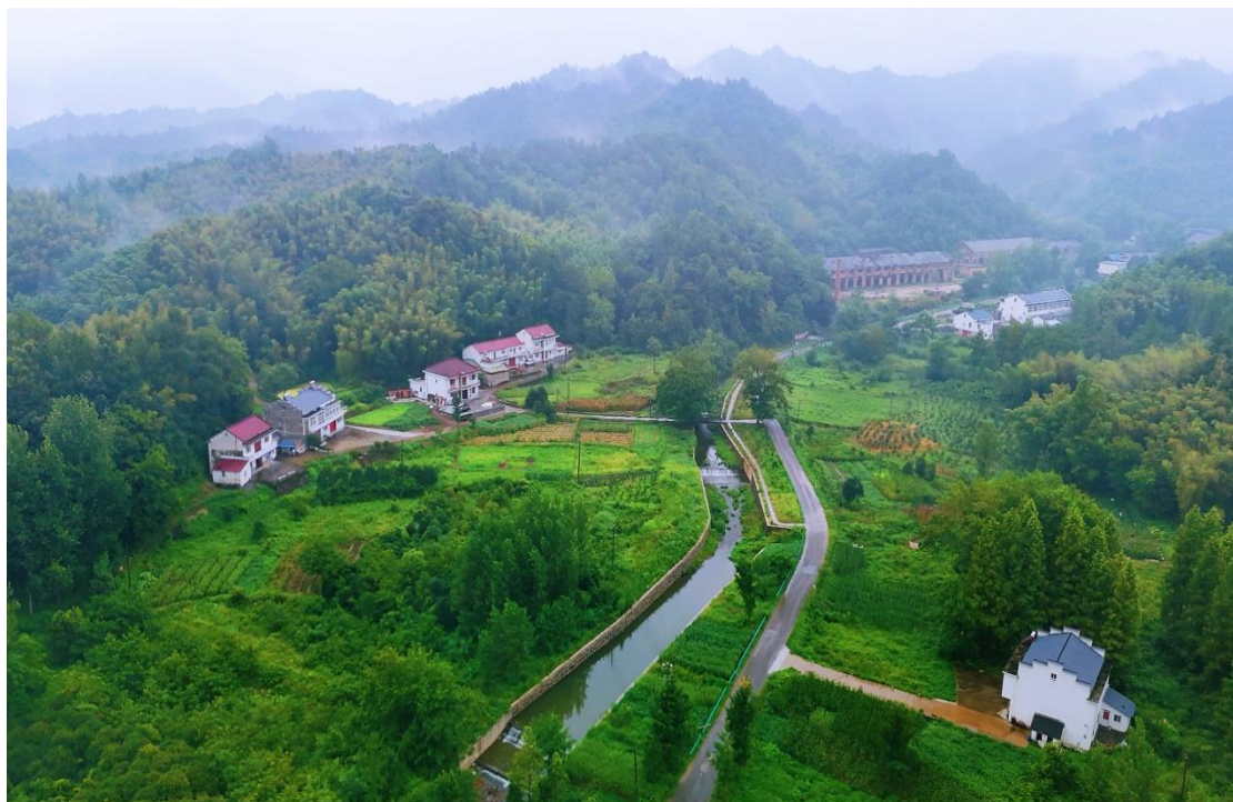
图3-5 金安区东石笋村小流域水土保持综合治理工程（护岸+拦沙坝）
