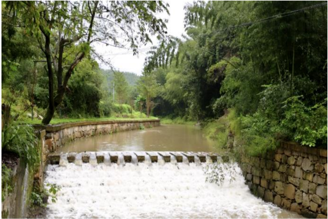
图3-3 霍山县张家湾小流域水土保持综合治理工程（拦沙坝）
