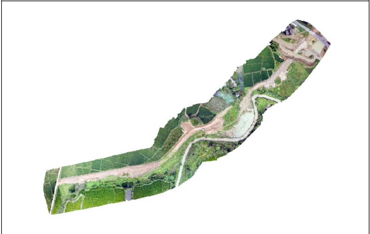
双河防洪工程新筑堤防无人机遥感影像
