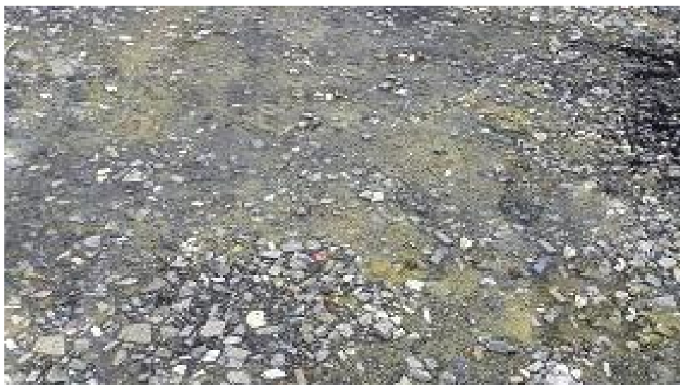
破桩头混凝土、砖渣等用作临时道路垫层
