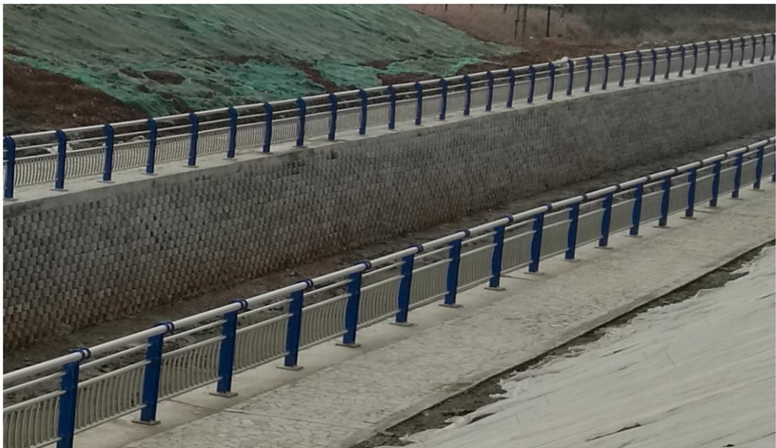
图 5.2-20 生态砼砌块挡墙断面
