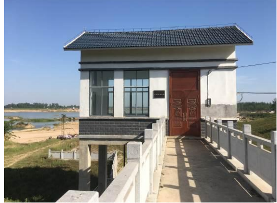
小淝河进水闸
