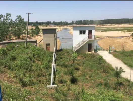
寿县隐贤取水口
