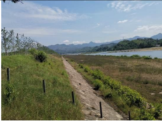
险工护坡生态恢复现状
