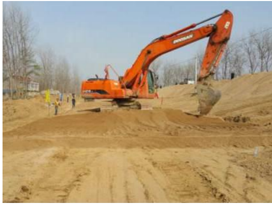
裕安段堤防填筑
