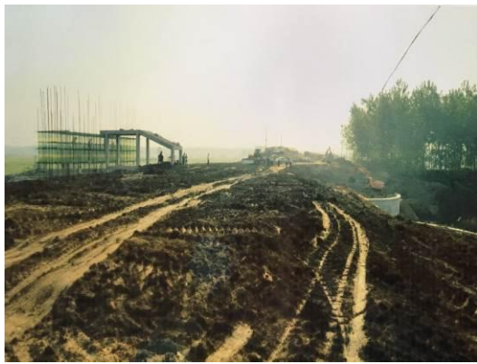
民生涵土方回填
