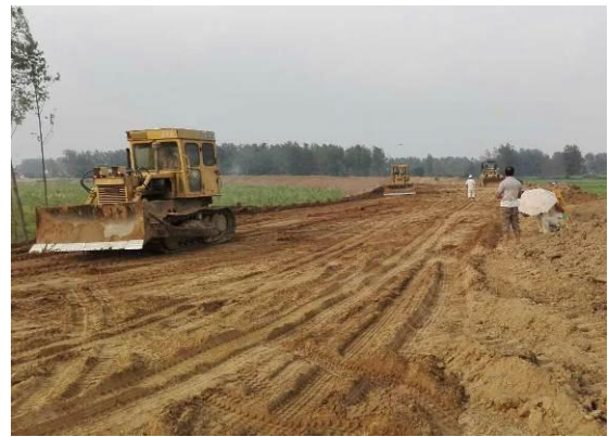
金安段堤顶整平
