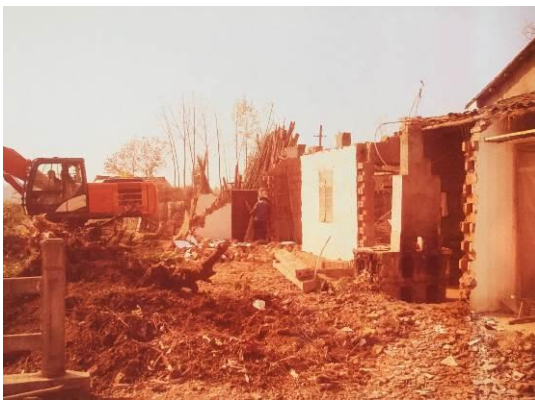
新沟桥头房屋拆迁
