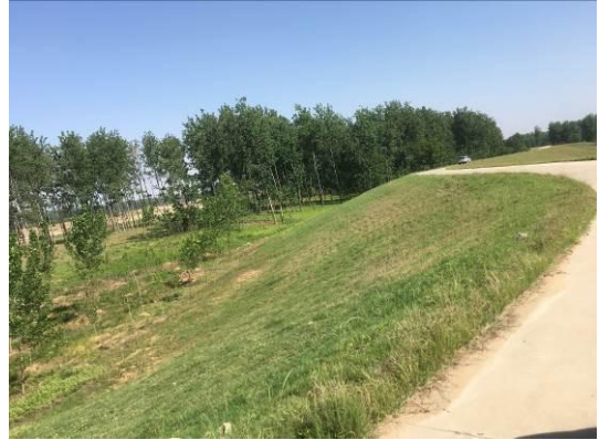
霍邱段护坡现状
