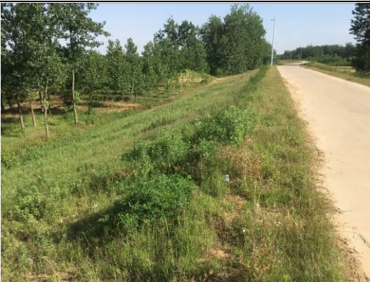
淠河左堤防浪墙加固
