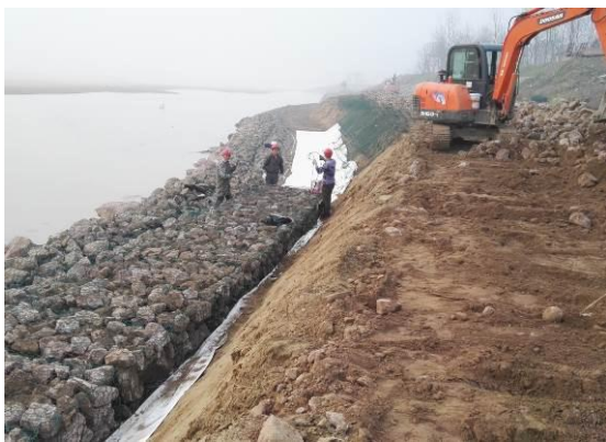
霍邱段护岸工程格宾石笼施工作业
