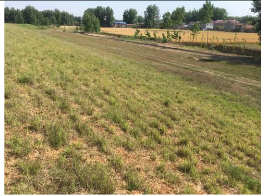
生态护坡恢复现状
