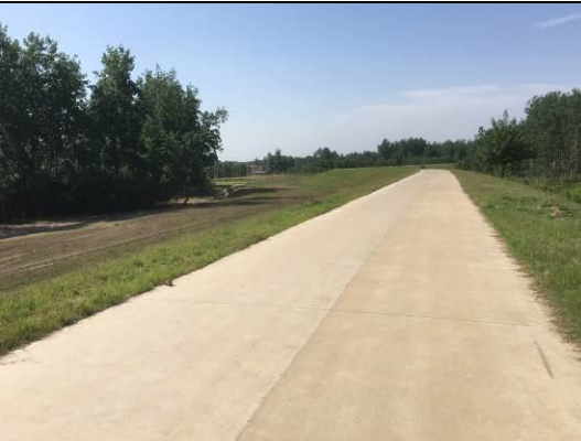
淠河左堤新建堤顶道路
