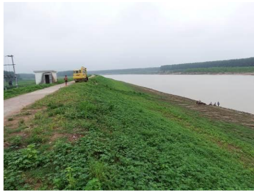
淠河左堤生态恢复现状
