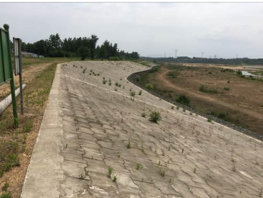
裕安区新建硬化护坡
