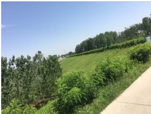
金安区生态护坡现状
