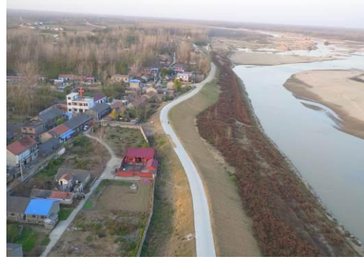
淠河右堤生态恢复现状
