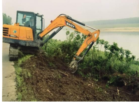
截渗墙施工清基
