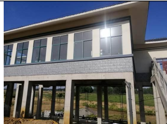
六安市区新建排涝涵
