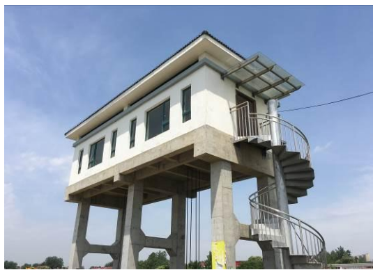
裕安区东沟排涝闸
