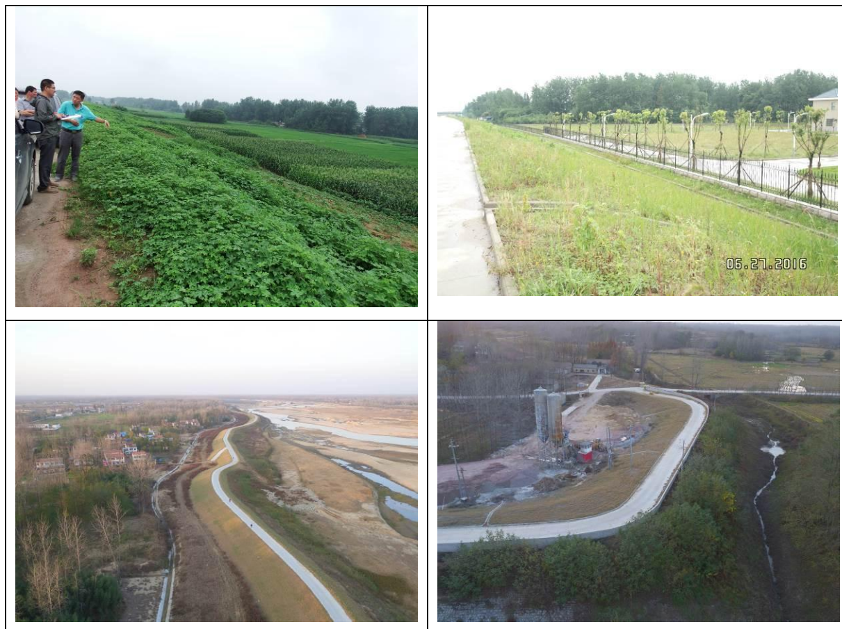
图 4-5 施工期生态恢复措施
