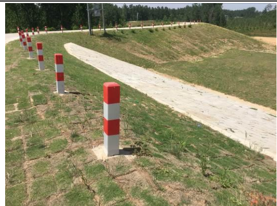
淠河右堤防浪墙加固堤防
