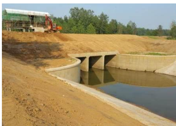
裕安段安城河3孔箱涵的整修边坡作业
