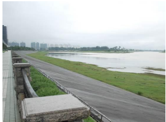
裕安区硬化护坡
