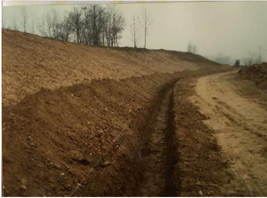
镇脚土方开挖
